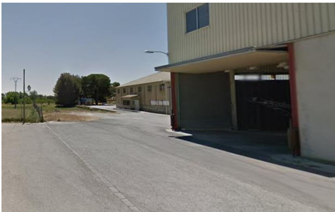
Figura 7. Zona donde está prevista la prolongación final de la calle Mayor
